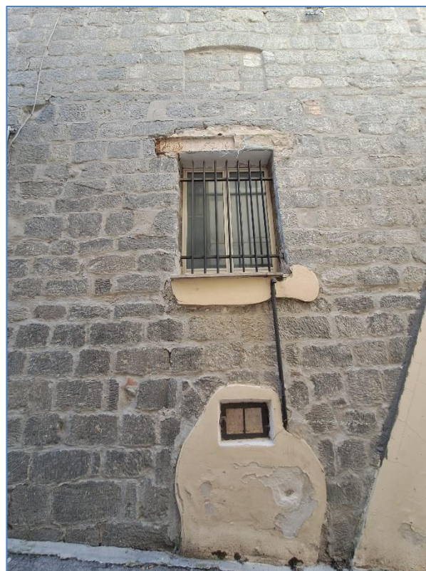
Foto 13. Muro con mattoni di gesso selenitico nel Comune di Gissi. Ph di V. De Luca.
