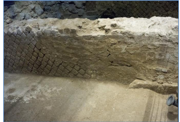
Fig. 9. Scavo via S. Tommaso, muro W dell'amb. 2 (foto C. Ossequio).
