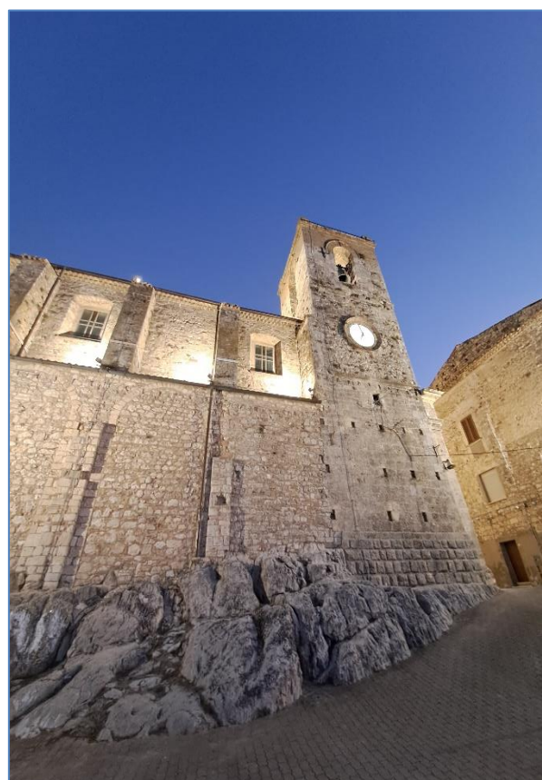
Foto 14. Chiesa del Santissimo Salvatore su affioramento di gessi, Fresagrandinaria. Ph di V. De Luca.
