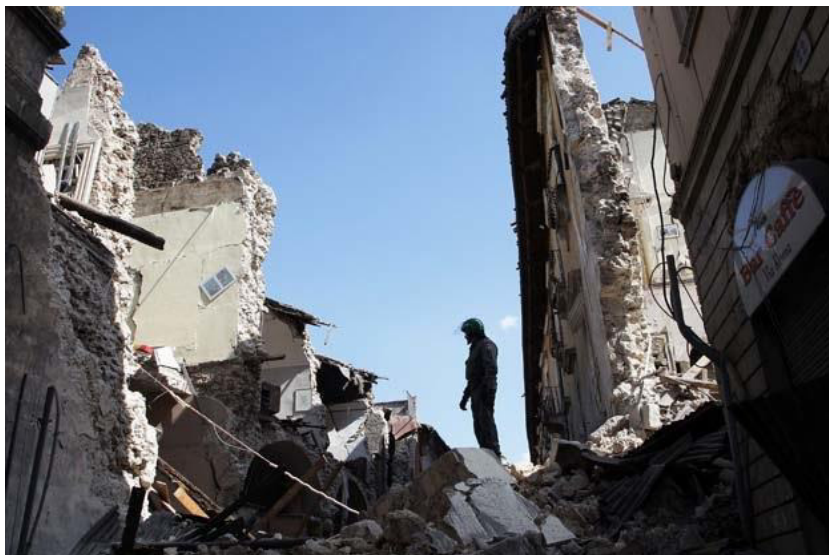
Figura 3-2: Controllo danni prodotti dal terremoto.
