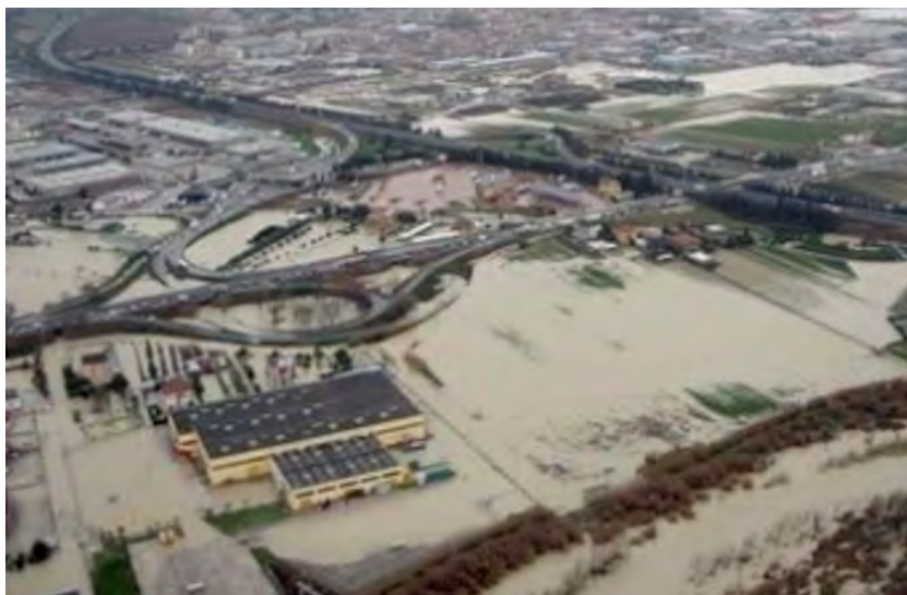
Figura 6-4: Esondazione del Fiume Tronto del 2011, località Sentina, San Benedetto del Tronto (Fonte foto: da LIFE PRIMES Technical Application Form).
